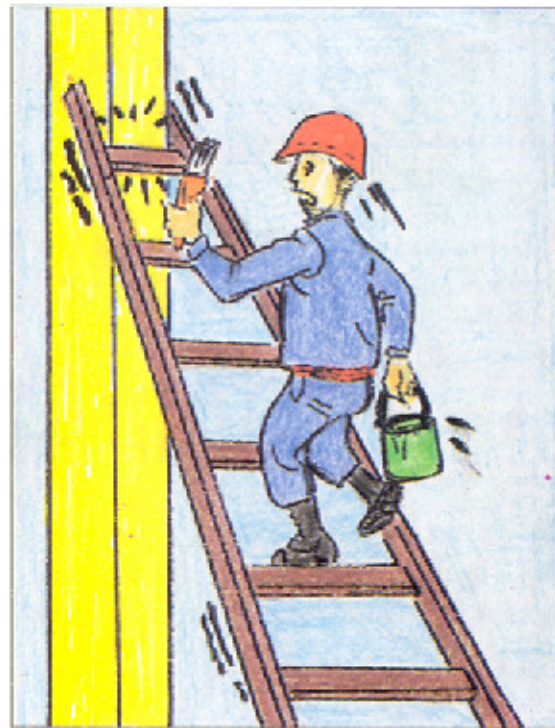
Phải tựa hai cột thang vào điểm tựa, không tựa bằng bậc thang
