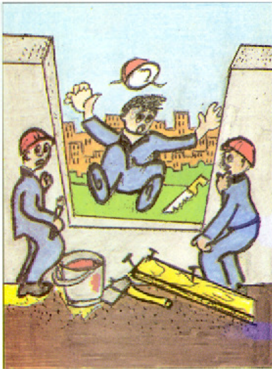
Phải che chắn lỗ cửa tường ngoài, hố thang máy để phòng ngã cao
